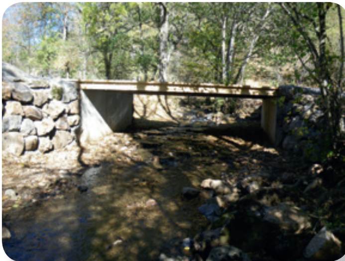
Pont en fin de chantier, crédit photo SIGAL
