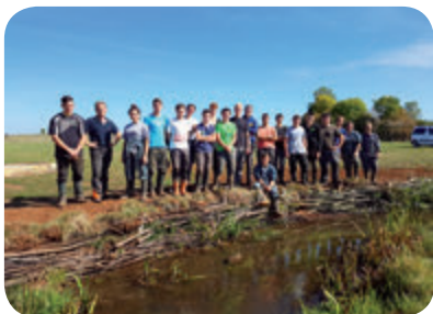
Aménagement des berges du ruisseau de « Liozargues » à l'aide des techniques de génie végétal
