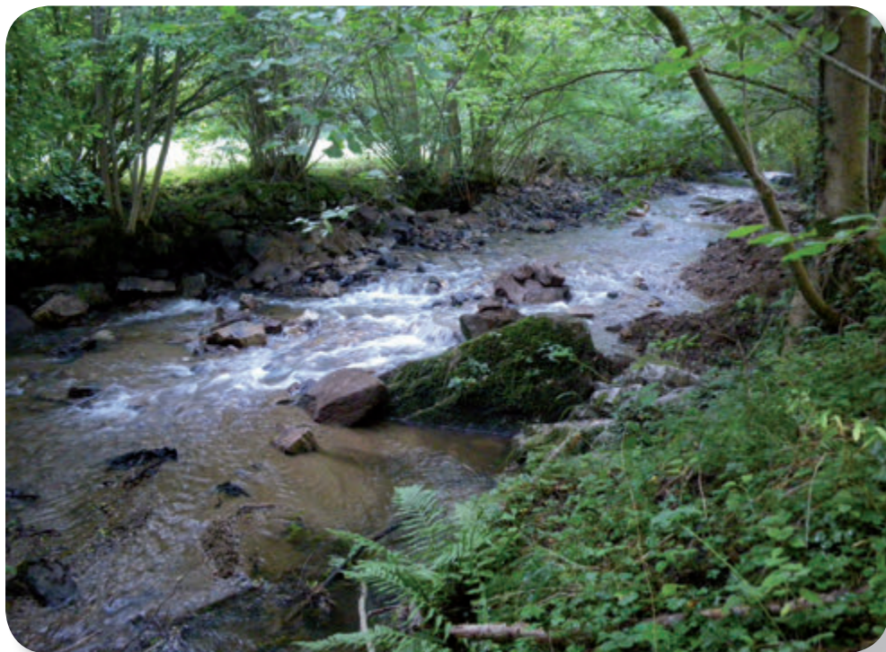
Seuil de Lagrange sur la Sianne après travaux, crédit photo SIGAL
