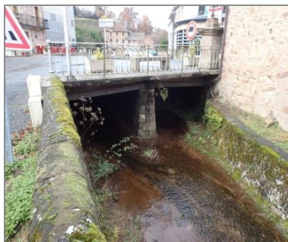
*Ouvrage de la RD 631 présentant une pile centrale et situé à l'entrée amont de la section busée
