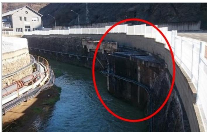
Zone de rétrécissement de la section d'écoulement sur le Riou Viou (Source : Decazeville Communauté)
