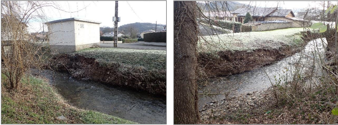
Signes d'érosion du système d'endiguement de la « cité Armand » suite à la crue de fin janvier 2018 (Source : SmCLm)
