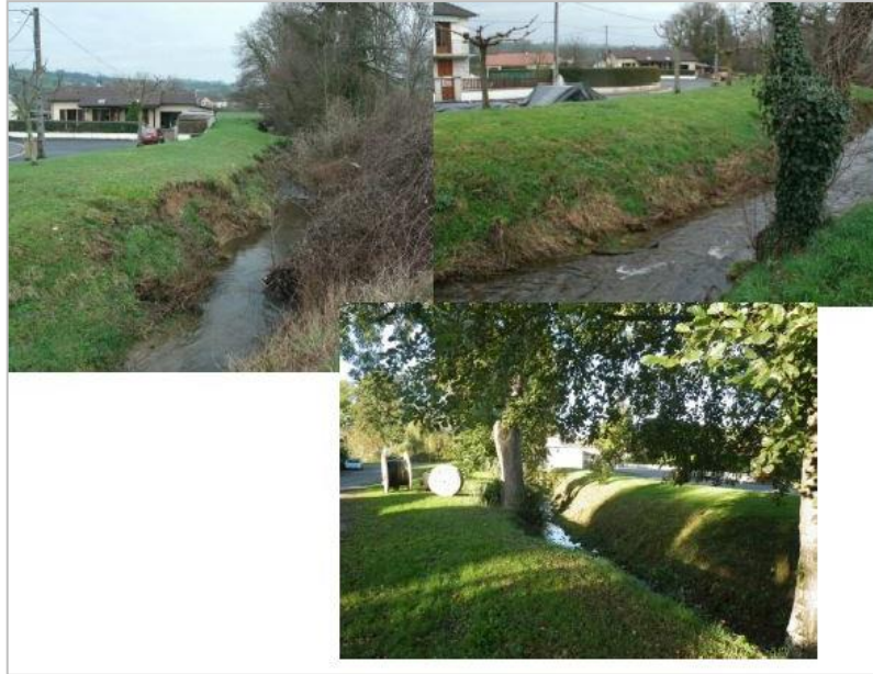
Système d'endiguement de la cité Armand, 2017 (Source : HYDRETTUES pour le compte du SmCLm)
